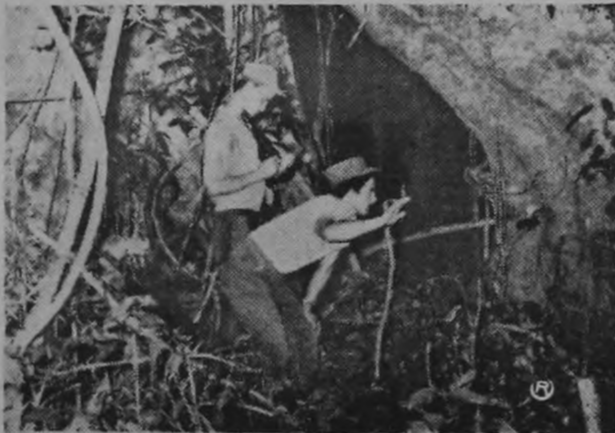
DOS INGENIEROS, observando a través de la maleza se disponen a tender los cimientos de un camino para que pase al equipo de construcción que está preparándose a cerrar la brecha constituida por el Tapón del Darién, de la Carretera Panamericana.
